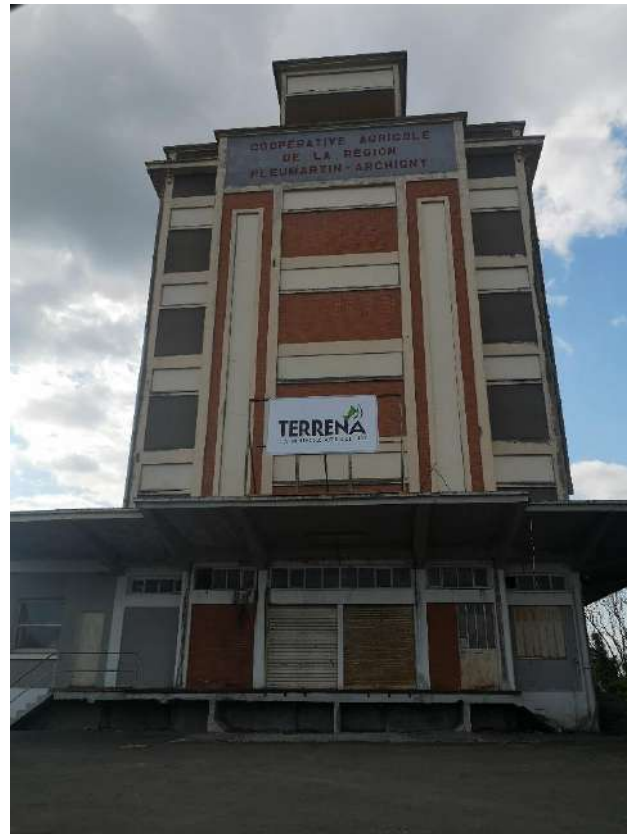
Figure 35 : Coopérative agricole Terrena à Pleumartin (Source : IDE Environnement, avril 2021)
